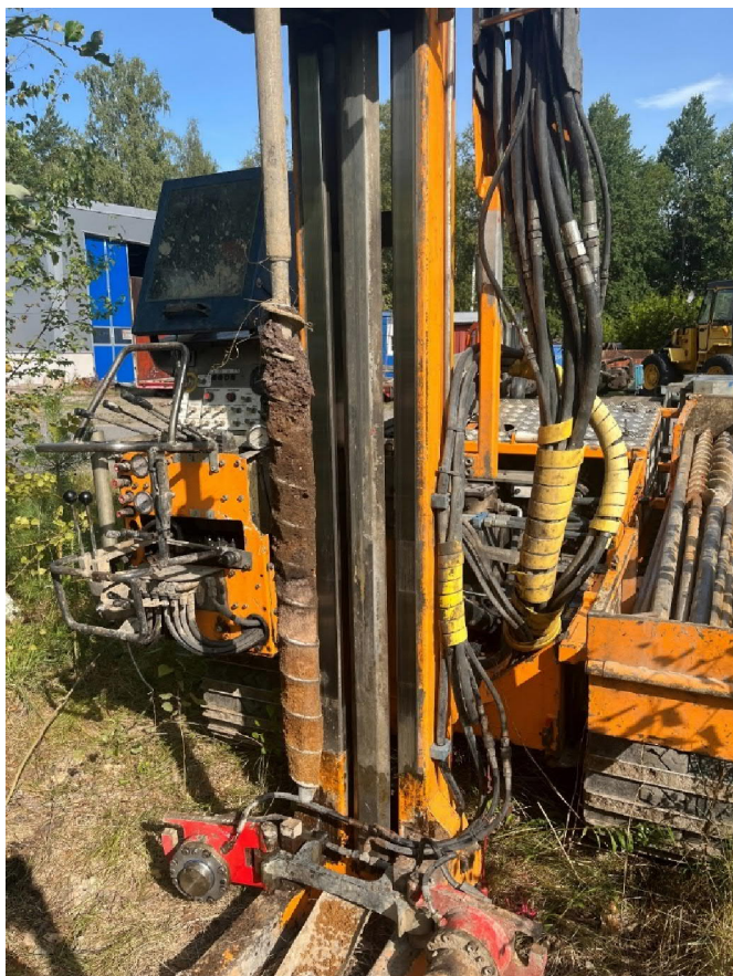
Figur 18. Skruvborring av provtagningspunkt BH/GV1. Ytlig geologi bestående av mulligt grusigt sandigt Fylle 0-0,5m. Följt av sand 0,5-1,0 m.
