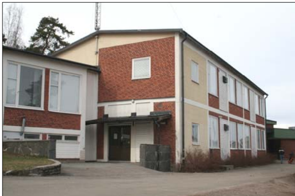
Den norra byggnadskroppen.
