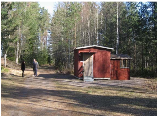
Service byggnad 2 (blivande 3).
